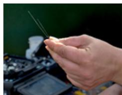
abonné du secteur. Cindy Cazanave, la cheffe d'équipe chargée du raccordement, réalise les connexions de chacune des fibres sur les prises. Celles-ci seront utilisées par les fournisseurs d'accès pour raccorder leurs abonnés au réseau.
